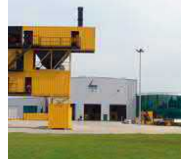
Завод компании LINSTAL в Польше
