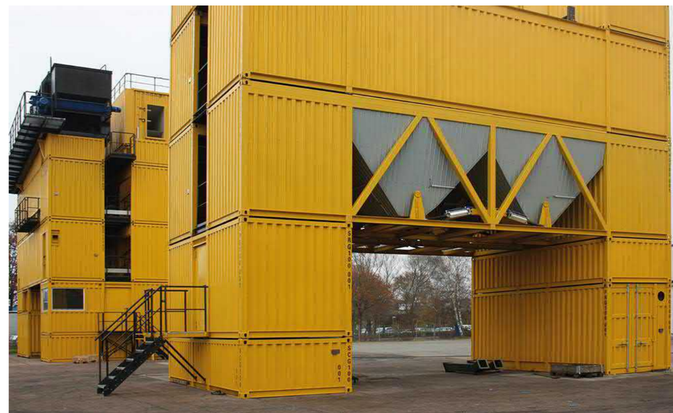
Встроенный бункер на 200 т для установок CSD и CSM
